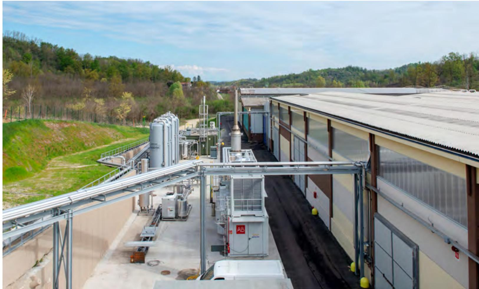
I rifiuti organici (scarti di cucina, sfalci e potature) conferiti presso l'impianto di San Damiano d'Asti vengono sottoposti a digestione anaerobica, con produzione di biogas. Il residuo del processo, denominato digestato, viene poi miscelato a sfalci e potature e subisce una digestione aerobica in biocella, trasformandosi in compost di qualità per l'agricoltura.
