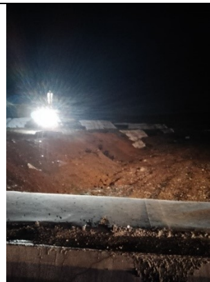
Foto 2 – termine lavori di spegnimento (23/04/2022 ore 22:20)
