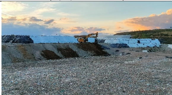
Foto 3– sopralluogo e ulteriore sistemazione dell'argilla (24/04/2022 ore 20:00)
