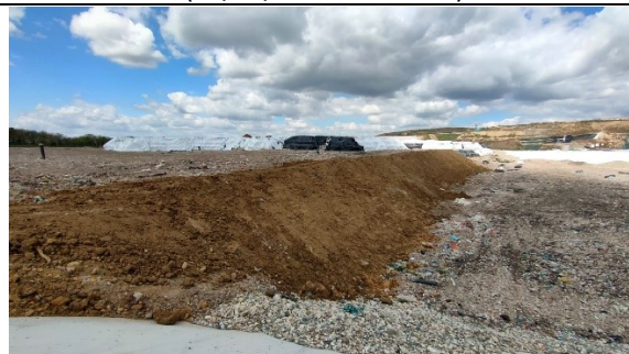
Foto 4– rifinitura ripristino area dell'incendio (24/04/2022 ore 15:42)
