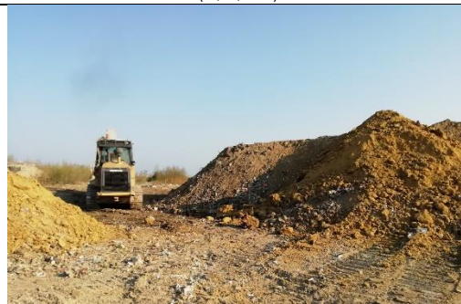
Foto 5: mezzi al lavoro sul luogo dell'incendio sabato mattina (05/09/2020)
